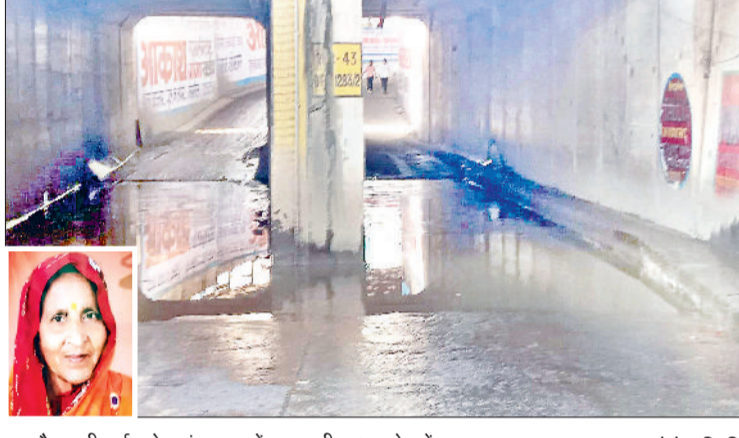
नारनौल। सीआईए रोड अंडरपास में भरा पानी व (इनसेट में) मृतका कमला। फोटो: हरिभूमि
